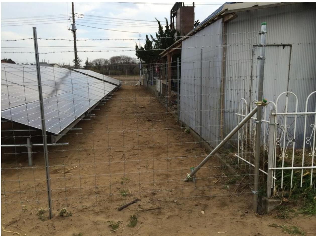
コーナー部にネカセを取り付けて、フェンスバンドでフェンスを取り付ける。
