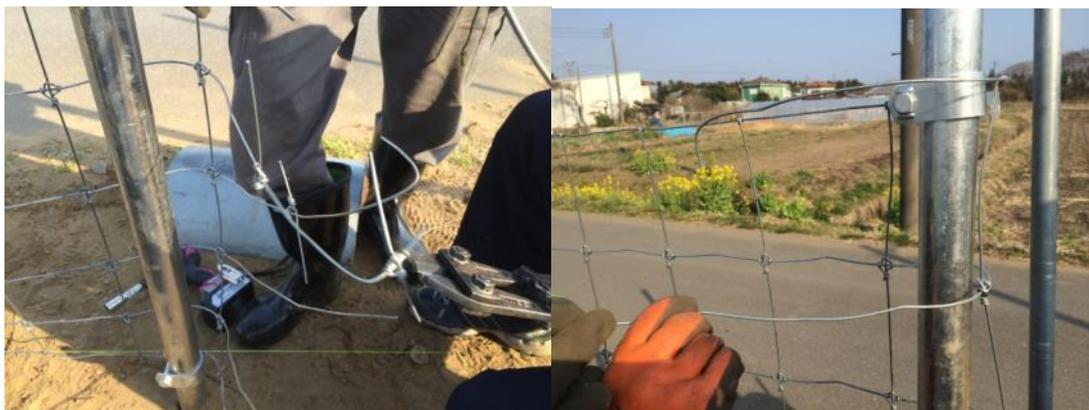
端部ポストにフェンスバンド使い、フェンスを固定する。フェンスバンドは上、中、下に取り付ける。フェンスの端部を図のように、不要部をカットし、端部ポストに図のように巻き付ける
