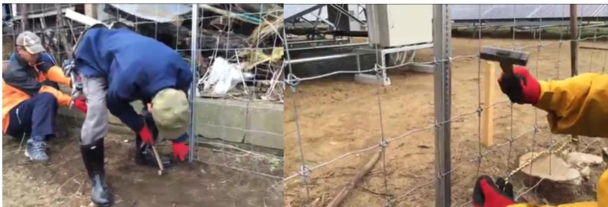
フェンスを伸ばしながら、ステイプルロックポストに、ステイプルをハンマーで打ち込み、フェンスを取り付ける。
